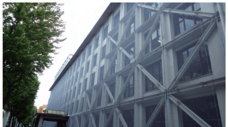
剥落防護ネット取付例
