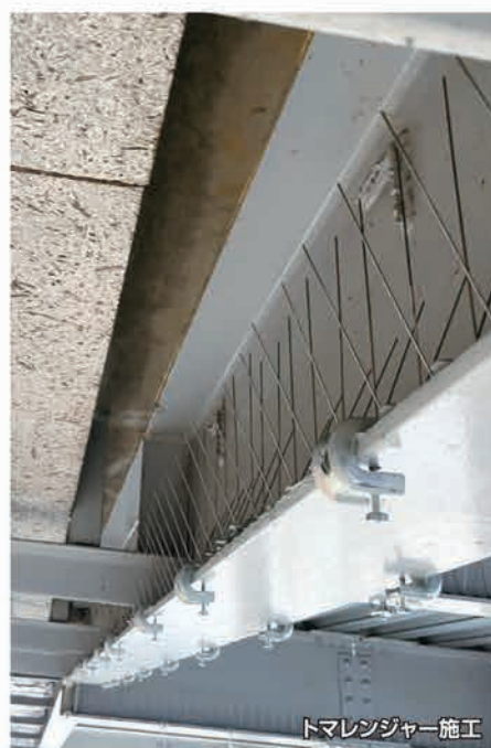
ネットクランプ工法+切り込み工法
