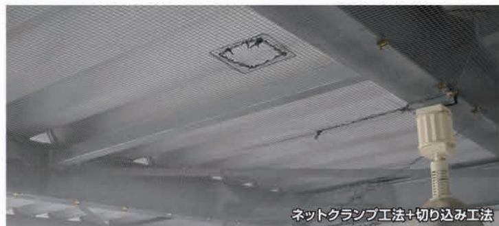
ワイヤークランプ工法+切り込み工法
